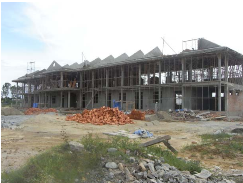
Le chantier de l'école en septembre 2009
